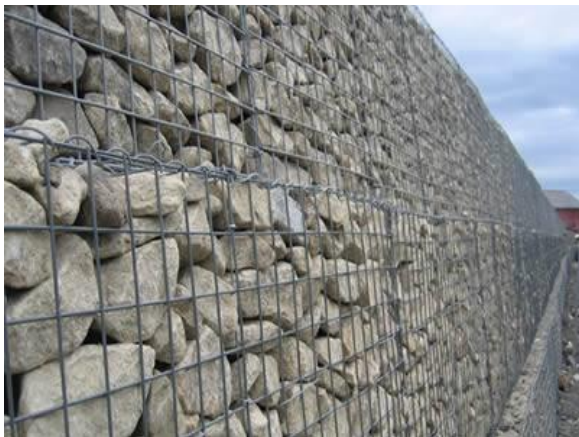
Figur 16: På billedet ses et eksempel på gabion med tætliggende sten tilbageholdt af armeringsjern.
